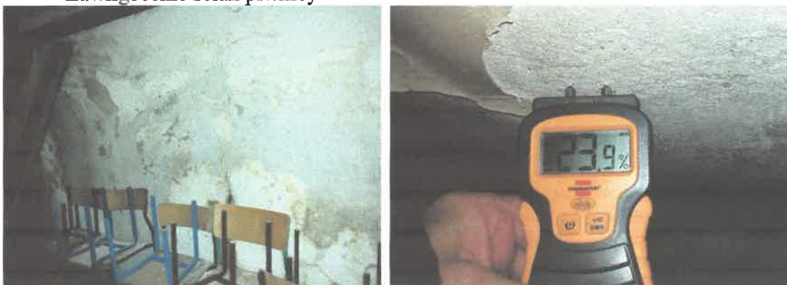
Zawilgocenie ścian piwnicy
