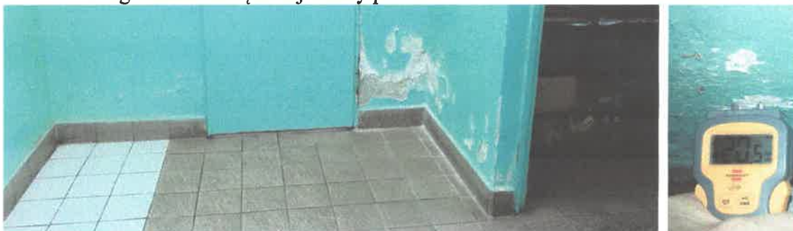
Zawilgocenie zewnętrznej ściany parteru
